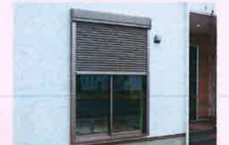
電動シャッター
